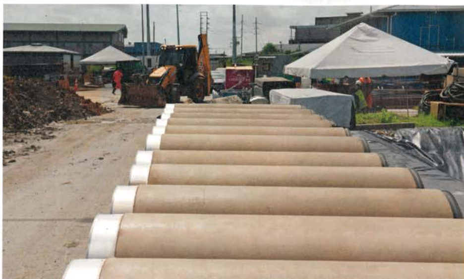
Abbildungen: meyer-Polycrete GmbH
