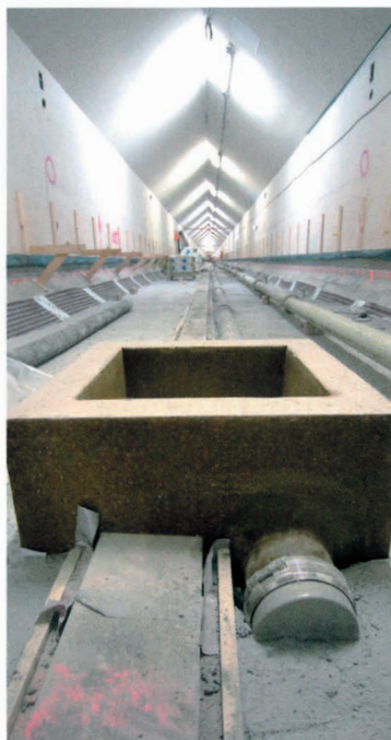
Die monolithisch gefertigten Ablaufschächten aus Polymerbeton der meyer-Polycrete GmbH überzeugten durch ihre Langlebigkeit und Korrosionsbeständigkeit.
